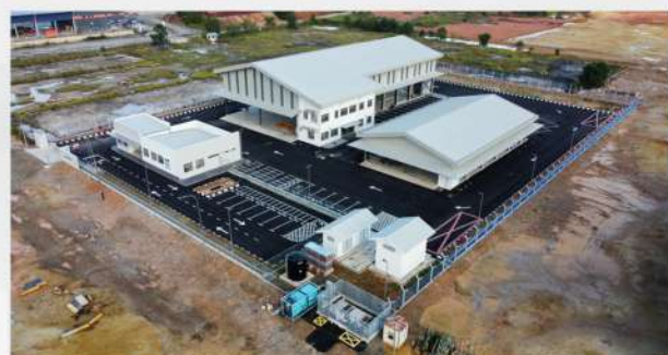
PENGERANG (SERVICE CENTRE)
